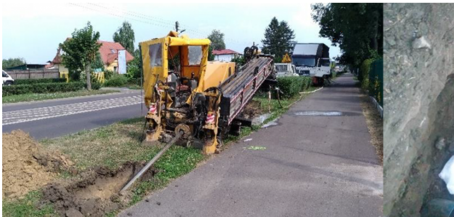
Fot. Nr 1. Modernizacja i przebudowa sieci wodociągowej w ulicy Zamojskiej.
