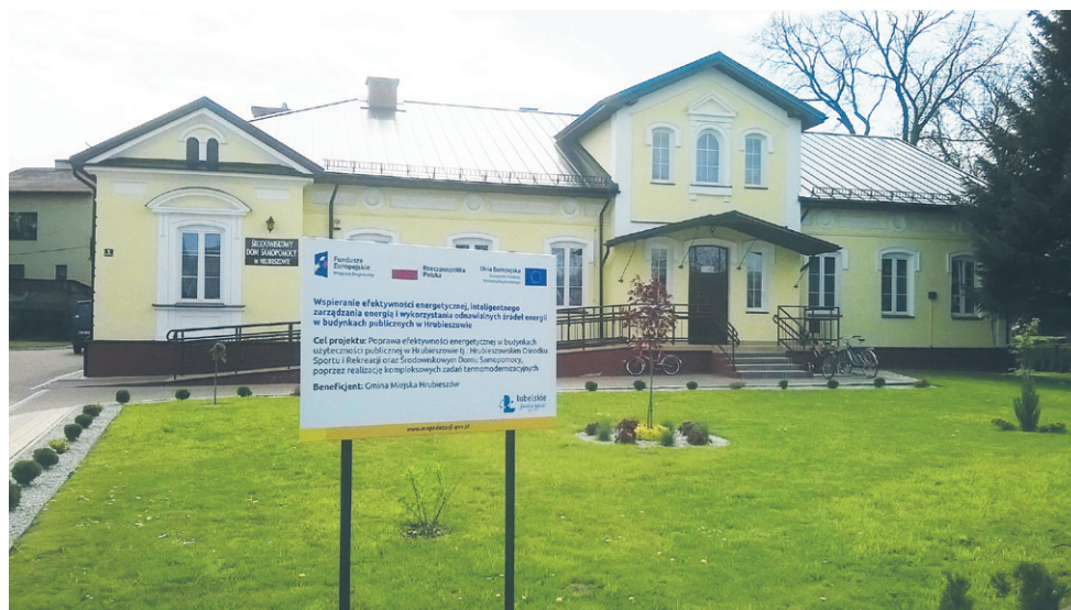
Miasto otrzymało również dofinansowanie na termomodernizację Środowiskowego Domu Samopomocy
